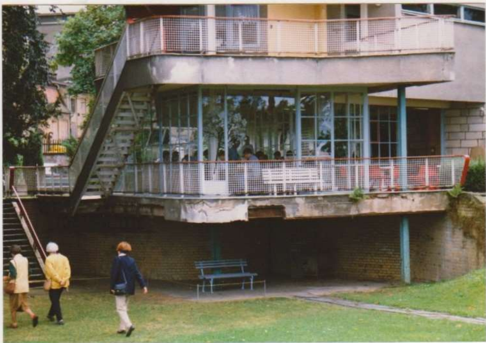
das FZZ von außen
